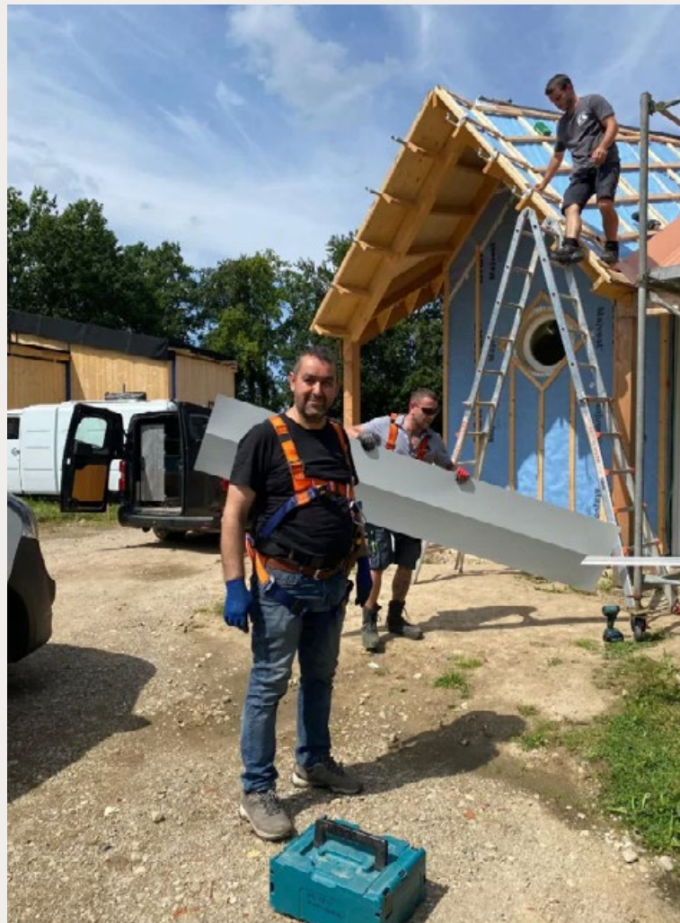
SALIH OP DE BOUWPLAATS
